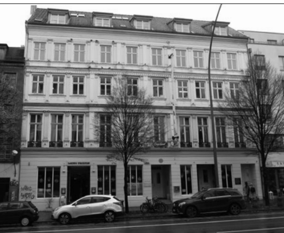
Heute ist das Gebäude am Valentinskamp aufwendig restauriert und kaum wiederzuerkennen. Foto: Holger Tillicki
