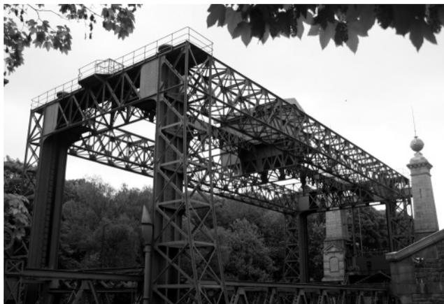
**Das alte Schiffshebewerk Henrichenburg. Der Trog wurde in dieser Konstruktion nicht hochgezogen sondern durch Auftriebskörper hochgedrückt. Das Verfahren ist sehr ökonomisch, da quasi nur die Reibung in dem Gerüst überwunden werden musste. Ein Elektromotor mit 110 kW war ausreichend. Foto: Ulrich Dübgen, 2010.**
