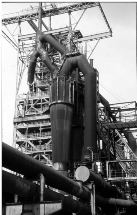
Museumshochofen der ehemaligen Heinrichrichshütte. Im Hintergrund ist der eigentliche Hochofen zu sehen. Die dicken Eisenrohre davor dienen dem Transport des Gichtgases. Es tritt oben aus dem Hochofen aus, wird dann hoch erhitzt und weiter unten wieder in den Hochofen eingeblasen. Das Gerüst um den Hochofen dient der Steuerung, Wartung und Versorgung. Foto: Michael Schöpzinsky, 2010.
