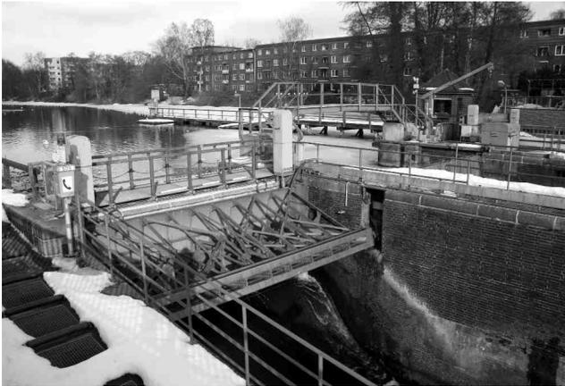
**Die Schleusenammer rechts wird von zwei Segmentwehren eingerahmt, mit denen der Wasserstand im Mühlenteich reguliert wird. Foto: Sven Bardua, 2010.**
