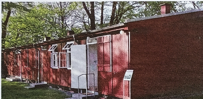
Die sanierte Baracke mit dem Informationszentrum Zwangsarbeit.
